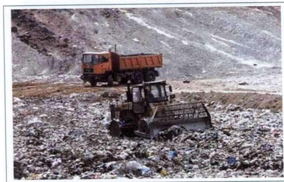
Слика бр. 3 - Планирање и набивање на отпадот
