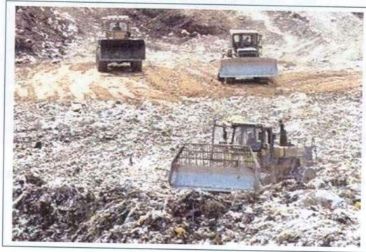
Слика бр 12 - Компактирање на отпадот и негово покривање со земја
